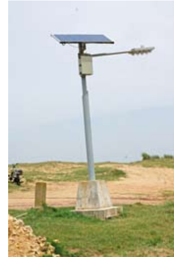
Δ Iluminación mediante paneles solares en la zona del cruce de balsas de la Laguna Garzón.
